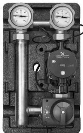
System ogrzewania podłogowego
