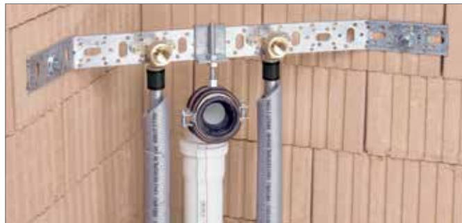
Rys. 5-3 Przykład wykorzystania szyny montażowej
