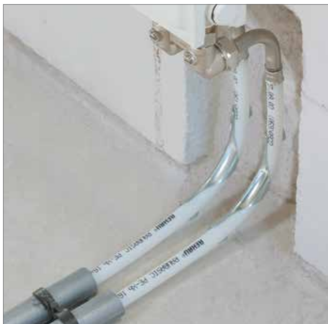
Rys. 5-6 Grzejnik ze zintegrowanymi zaworami przyłączony ze ściany kątownym garniturem przyłączeniowym RAUBASIC
