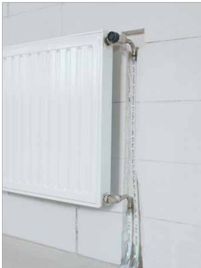
Rys. 5-1 Podłączenie do grzejnika kompaktowego przy pomocy kąтового garnituru przyłączeniowego RAUBASIC
