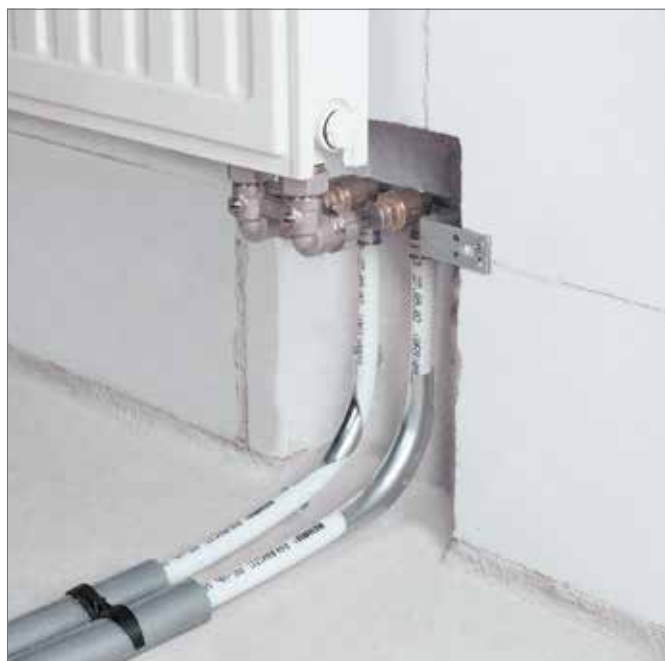
Rys. 5-7 Grzejnik ze zintegrowanymi zaworami przyłączony krótkim kolankiem ściennym RAUBASIC 16-Rp1/2 montowanym na uchwycie REHAU O 50
