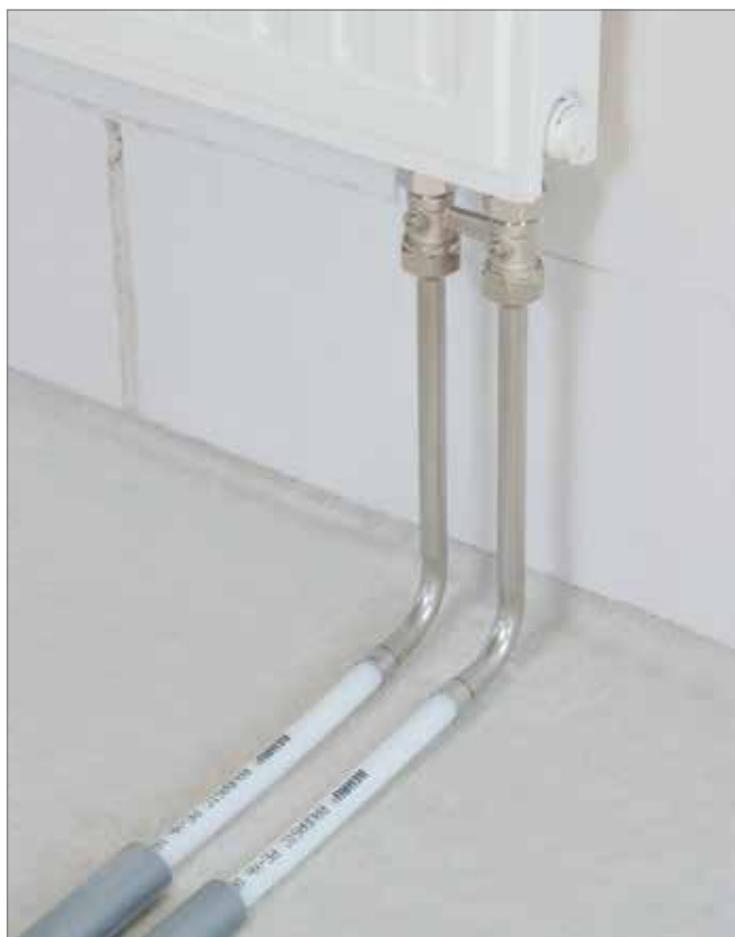
Rys. 5-4 Podłączenie grzejnika ze zintegrowanymi zaworami przy pomocy kąтового garnituru przyłączeniowego RAUBASIC z podłogi
