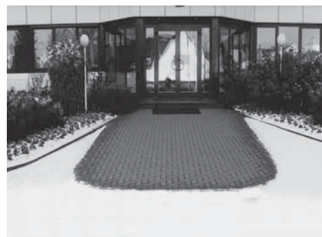
Rysunek 115 Ogrzewanie podłogowe na otwartych przestrzeniach
