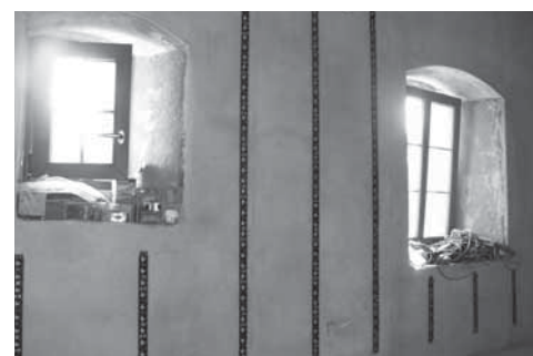
Rysunek 33 Railjet montaż listew (instalacja wykonana przez partnera Purmo we Wrocławiu)
