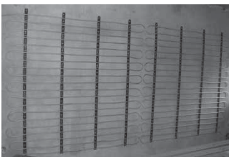
Rysunek 35 railjet montaż systemu ściennego (instalacja wykonana przez partnera Purmo we Wrocławiu)
